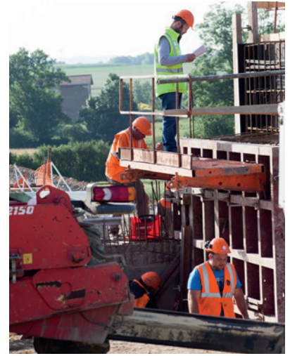
i Une opération du plan de relance autoroutier d'APRR
